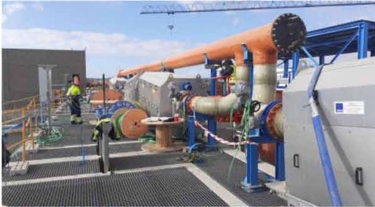
agua apuesta industria y innovación desarrollar infraestructuras resilientes
