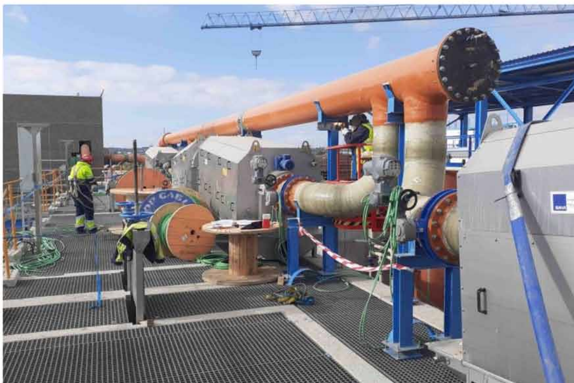
Aqualia Industrial desarrollo el diseño y construcción de la depuradora de AITASA, en el polígono petroquímico mas grande del sur de Europa copia
